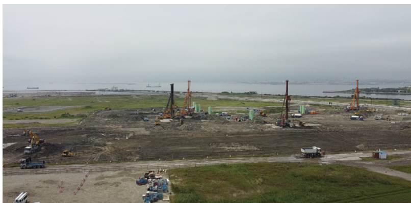
カジノの工事は順調のようだ。トラックが出入りし、何本か塔が見える。 メタンガス抜きと地盤改良のためか？
